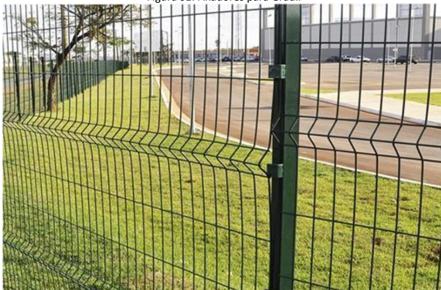
Figura 01: Fixadores para Gradil
