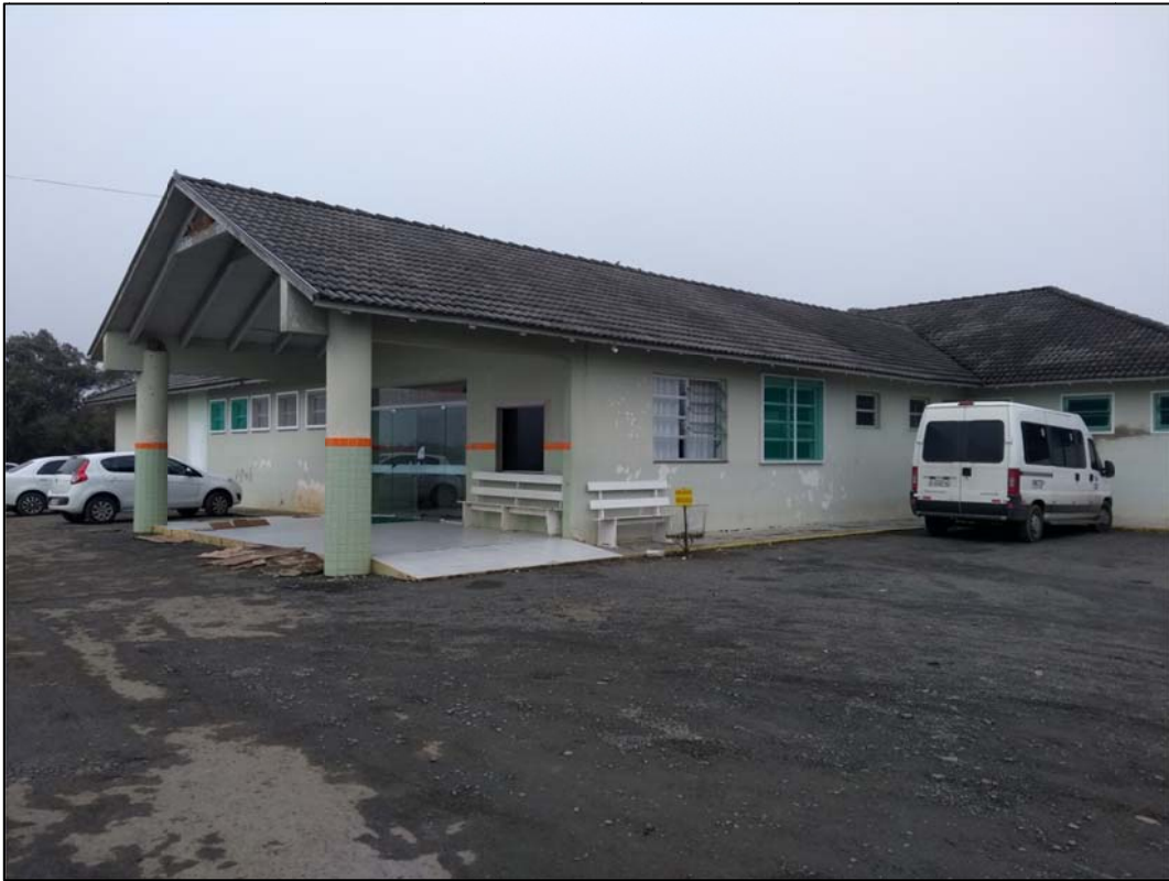
Foto 4.4 -Local de implantação da ampliação.
