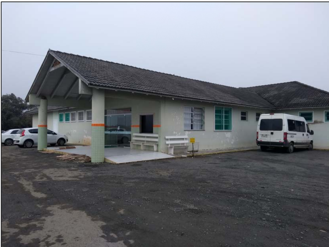
Foto 4.3 -Fachada da unidade de saúde existente.
