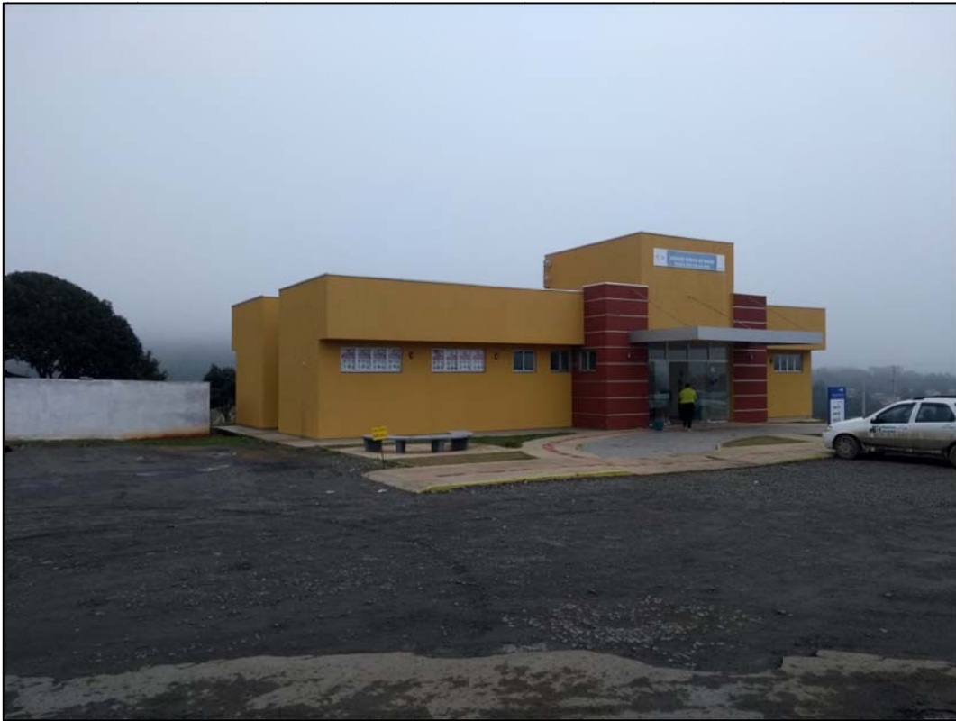
Foto 4.2 – Fachada da secretaria de saúde de Monte Castelo.
