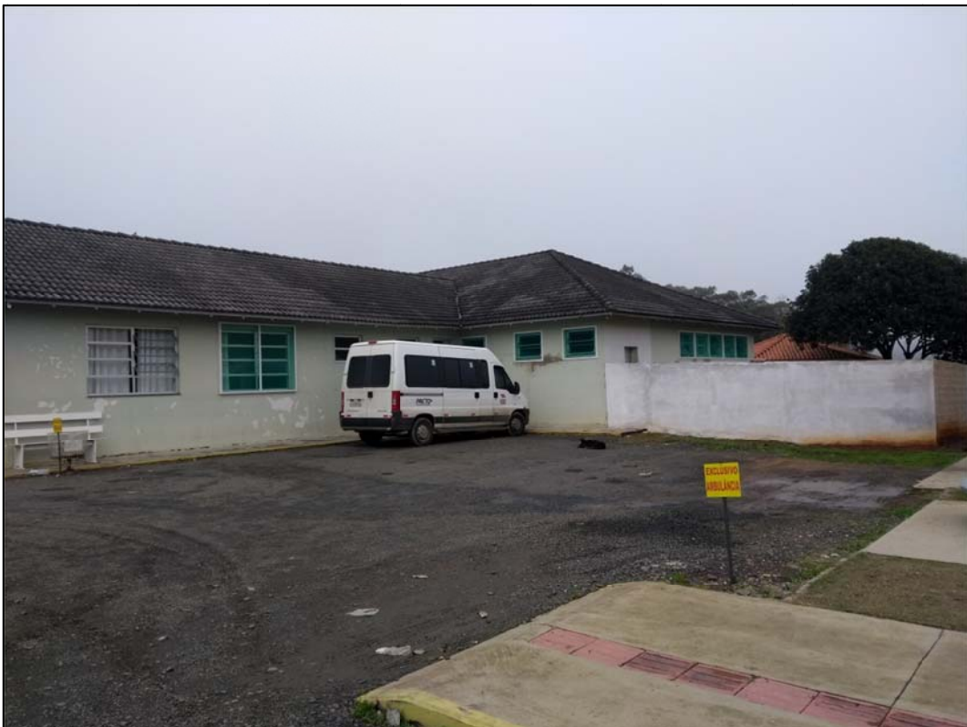
Foto 4.5 – Local de implantação da ampliação.
