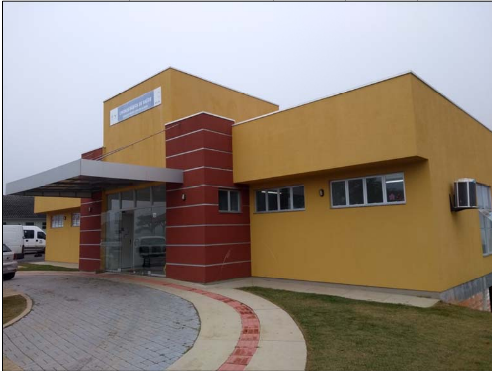
Foto 4.1 – Fachada da secretaria de saúde de Monte Castelo.
