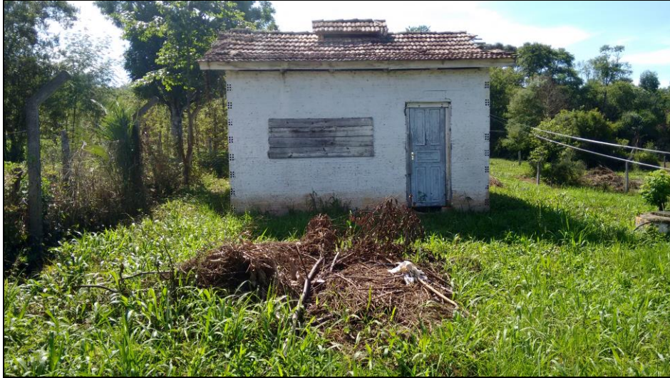
Figura 1 - Obra a ser demolida
