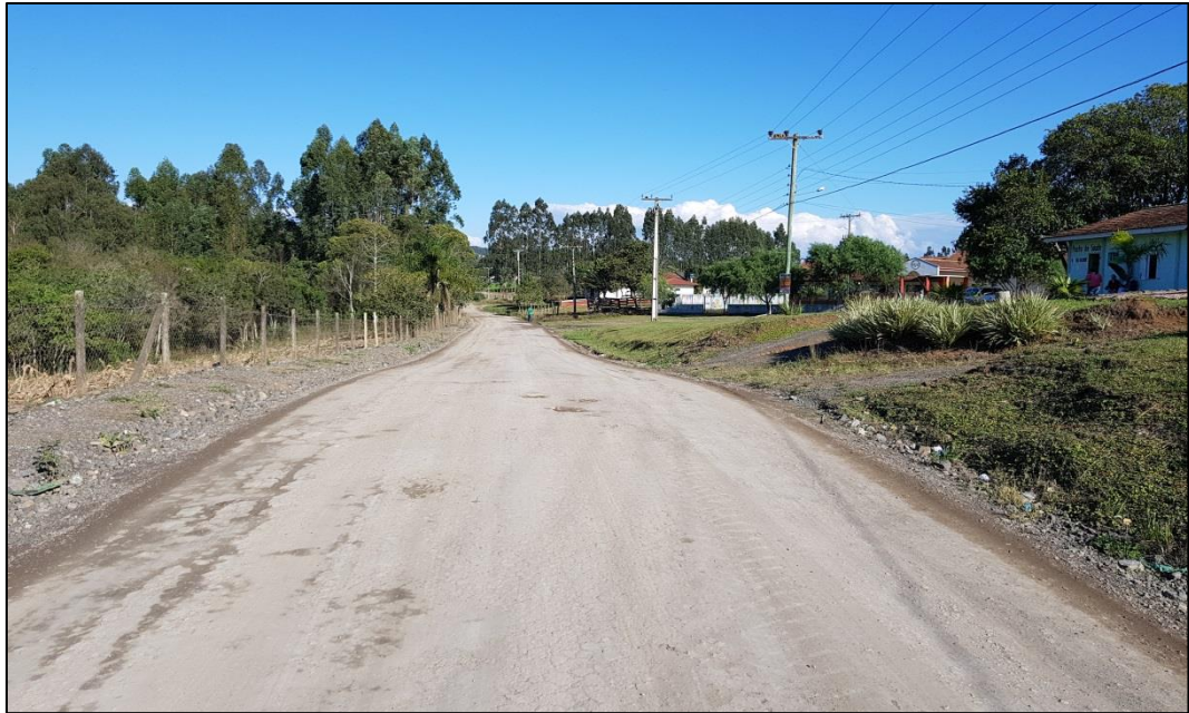
Figura 3.9 – Estaca 2+680 – Trecho da igreja, posto de saúde e escola.
