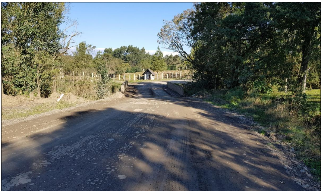
Figura 3.8 – Estaca 2+460 – Ponte existente.
