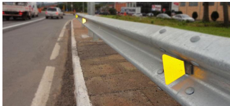
Figura 3.12 - Refletivos para defesa metálica.
